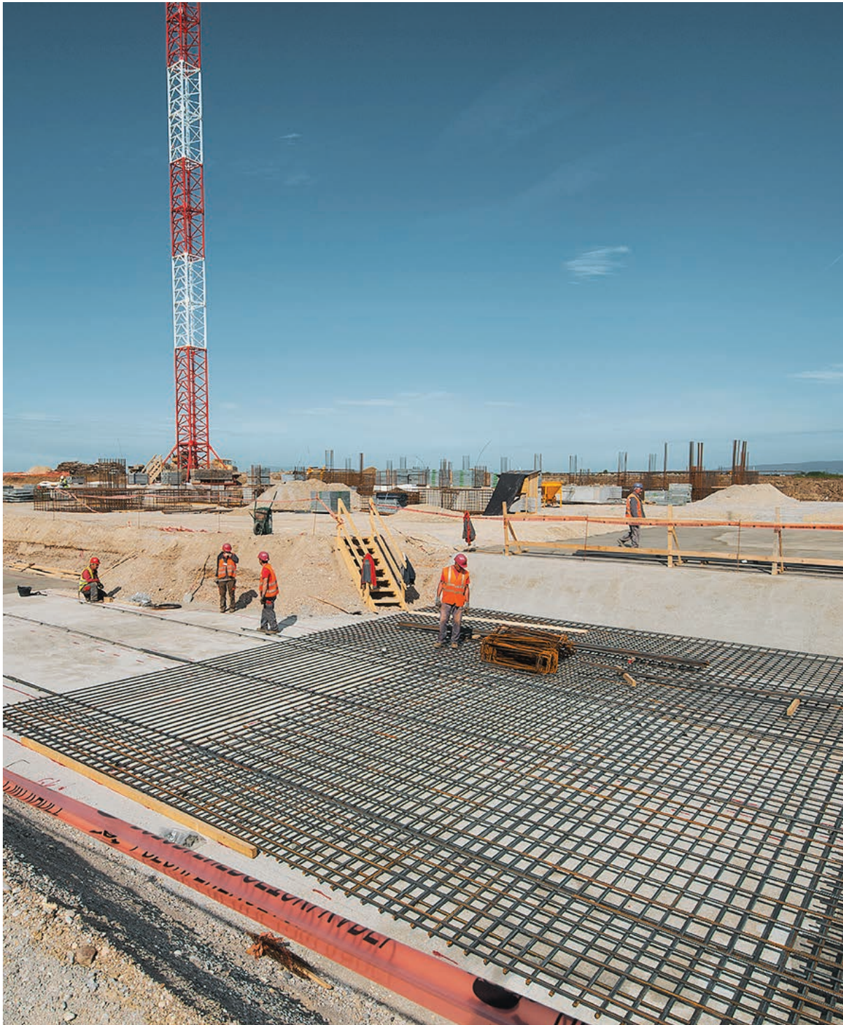
工人修建萨格勒布国际机场的一个候机楼。这个项目将为克罗地亚的基础设施和旅游业提供支持。
