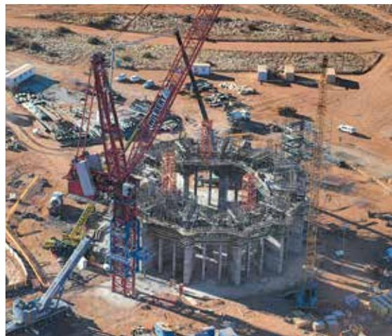
左上：IFC は南アフリカで初の集光型太陽熱発電所の建設を支援しています。この方式は、反射板を用いて太陽光を集光し、その熱で蒸気を発生させ、タービンを回転させて発電します。
