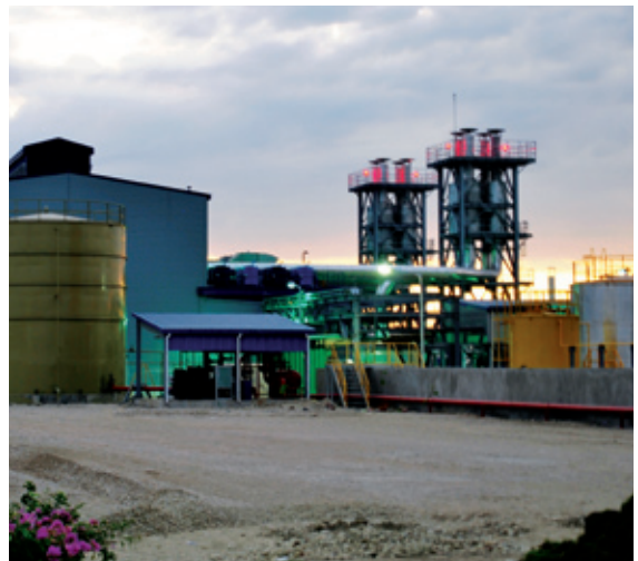
上图：E-Power 在太子港供电设施，工人进行收尾阶段的施工。
