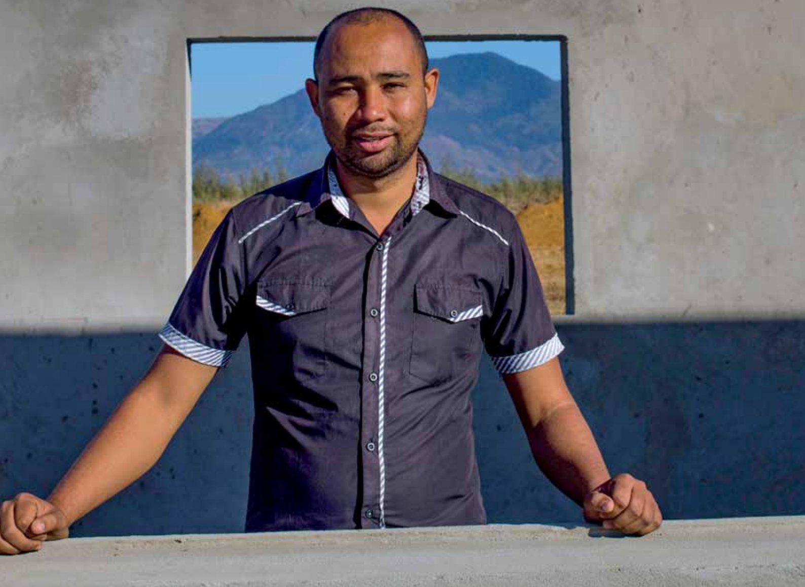
Photo : Jackie Adriano est maître d'œuvre à BoViMa, un client d'IFC qui a entrepris de construire un parc d'engraissement et un abattoir de classe internationale.
