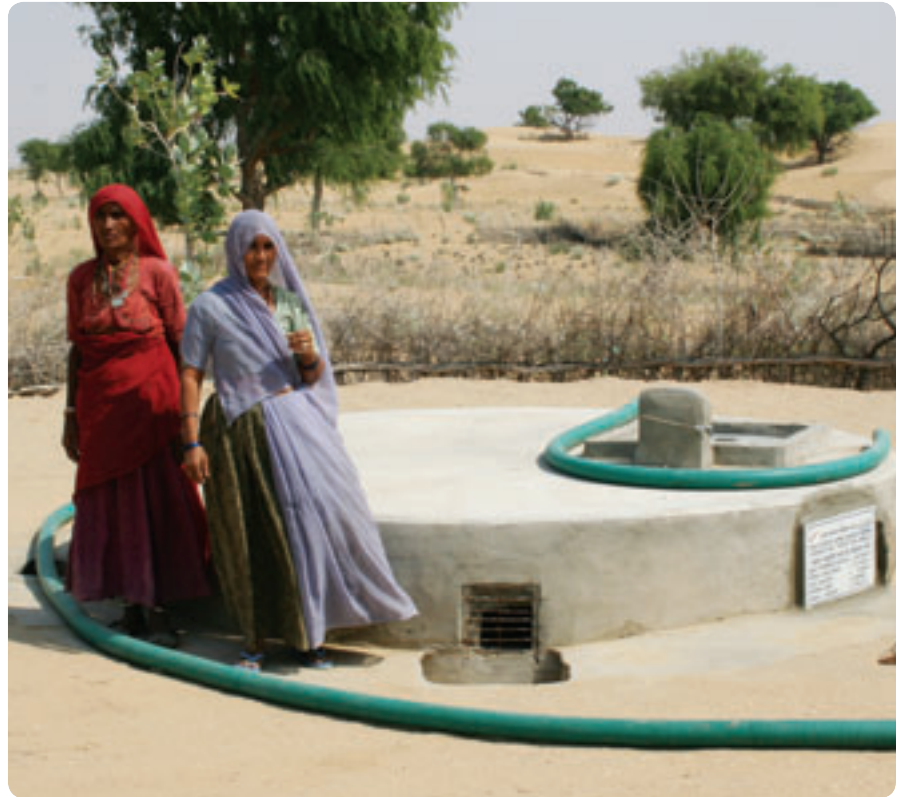
Un pozo recolector de aguas lluvias desarrollado como parte de un programa de asistencia técnica en Rajastán (India) acortará la distancia que deberán recorrer las mujeres del lugar para buscar agua.
