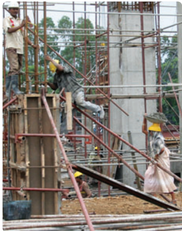
Obras de ampliación de Andhra Pradesh Paper Mills en la India.
