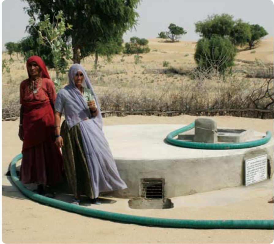
Un système de puits à drains rayonnants pour capter l'eau mis au point dans le cadre d'un programme d'assistance technique au Rajasthan (Inde) réduira la distance que doivent parcourir les femmes pour aller chercher de l'eau.
