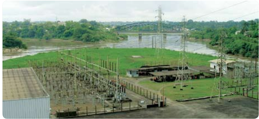
Centrale de l'AES Sonel au Cameroun.
