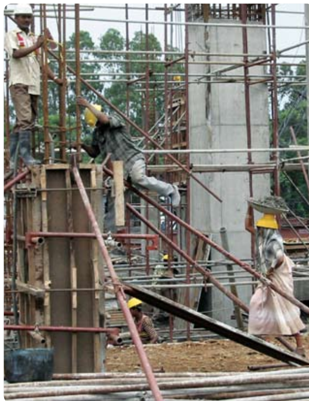
Travaux d'agrandissement de l'usine d'Andhra Pradesh Paper Mills en Inde.
